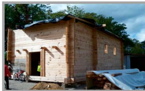
Cerkiew z Kupnej w trakcie budowy, fot. arch.LGD KE 2012 r.
